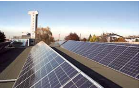
La sede di Schindler Italia a Concorezzo (MB)
