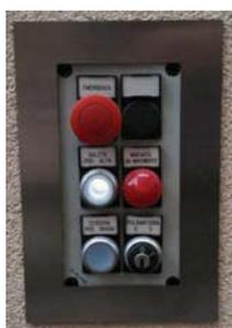
Pulsantiera di comando incassata a muro completa di profilo in acciaio, posizionata il più possibile vicino all'impianto di sollevamento, in modo tale da avere una completa visuale dello spazio circostante
