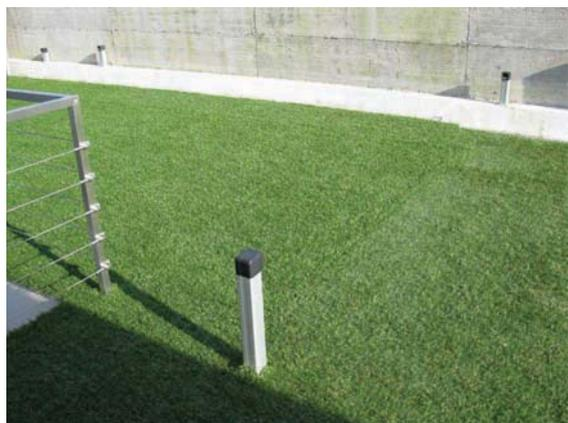
Ogni impianto dotato di tetto di copertura necessita obbligatoriamente di protezioni perimetrali costituite da fotocellule in grado di creare una barriera protettiva tra il tetto di copertura e l'ambiente circostante.
