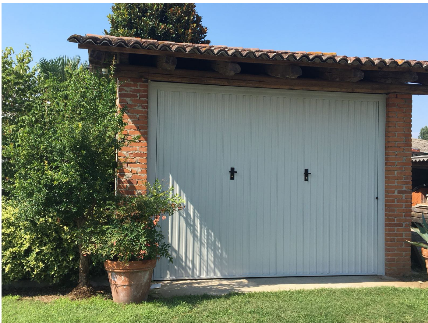
Porta basculante metallica verniciata RAL 9010
