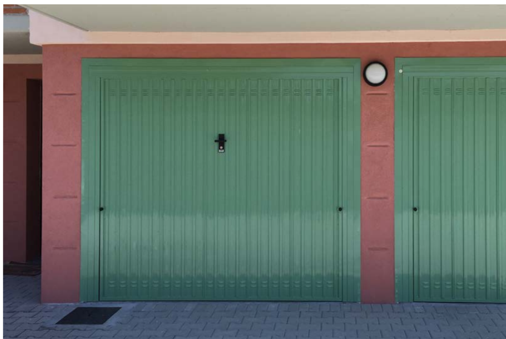
Porta basculante metallica verniciata RAL 6021 con fori a cappuccio
